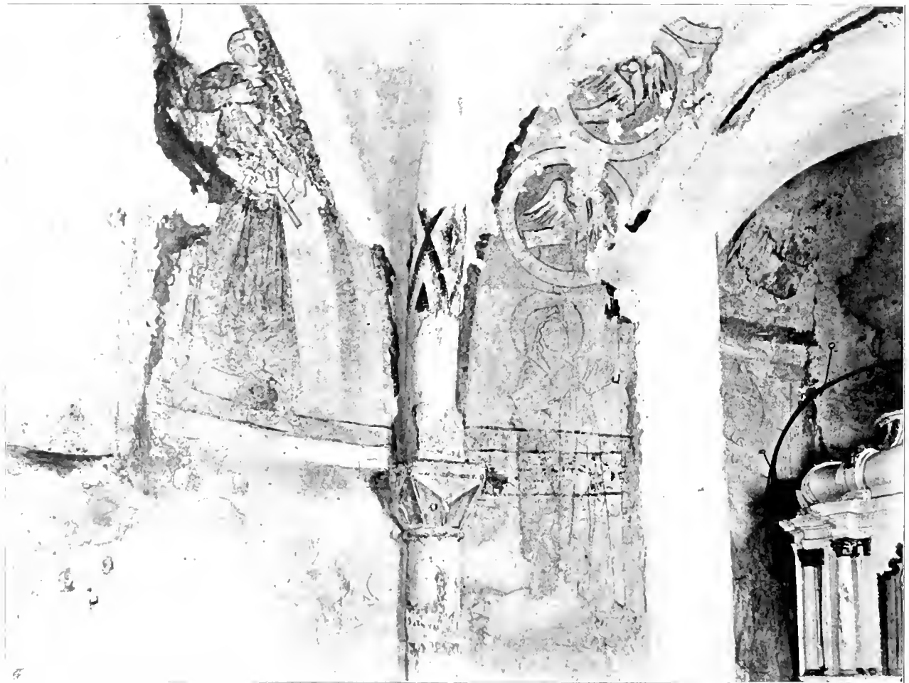
Fig. 18* Der jetzige Zustand der Malereien im Karner von Mauthausen
